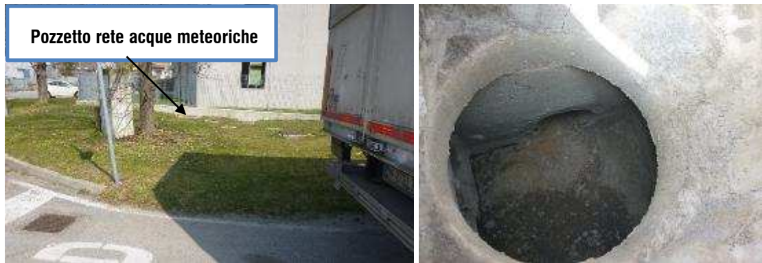
Figura 4: Fotografie pozzetto rete acque meteoriche
